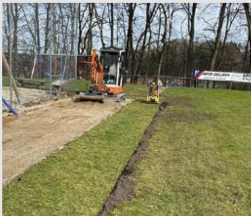
Die ständige Weiterentwicklung und Aufwertung des Sportgeländes schreitet voran. Für die geplante Flutlichtanlage und zur einfacheren Handhabung der Sportplatzbewässerung wurde ab dem Vereinsheim parallel zur Torauslinie ein Leerrohr sowie eine PE-Wasserleitung verlegt. Erste infrastrukturelle Grundlagen dafür wurden schon beim Neubau des Sportheims geschaffen.
